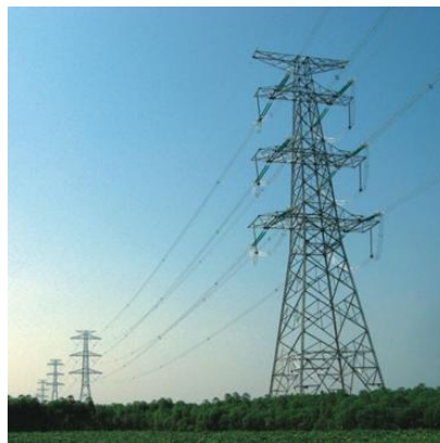
Gambar 1. Menara transmisi baja sebagai representasi struktur lattice tower
